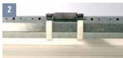
2 Schnellverbinder und Befestigungsringe auf die Welle legen
